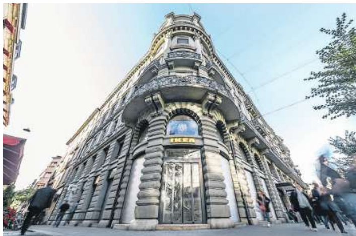
Im Moment befindet sich an der Bahnhofstrasse 89 noch ein Ikea-Pop-up-Store. Die Umbauarbeiten beginnen im Februar 2018. Bild: PD
